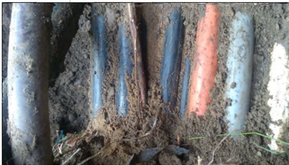
foto č.1: kopaná sonda s vyznačenými sítěmi
