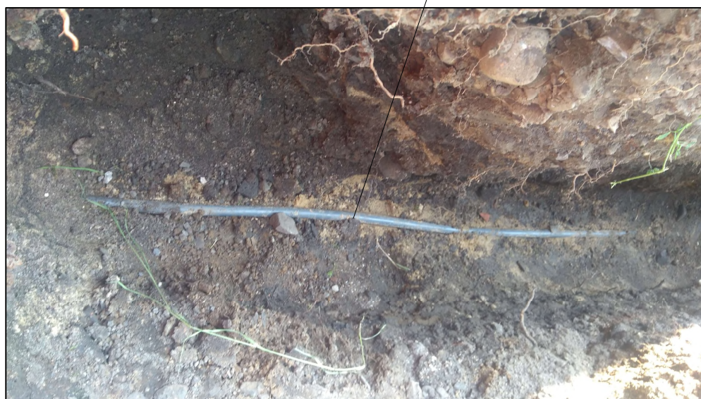
foto č.1: kopaná sonda s vyznačenou sítí CETIN
